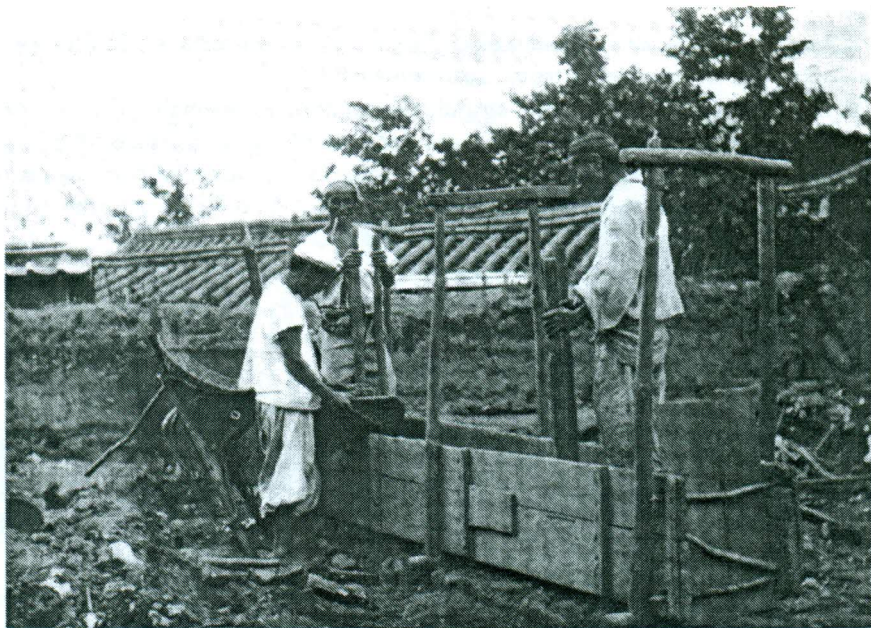
COSTRUZIONE DI UN MURO DI FANGO.
