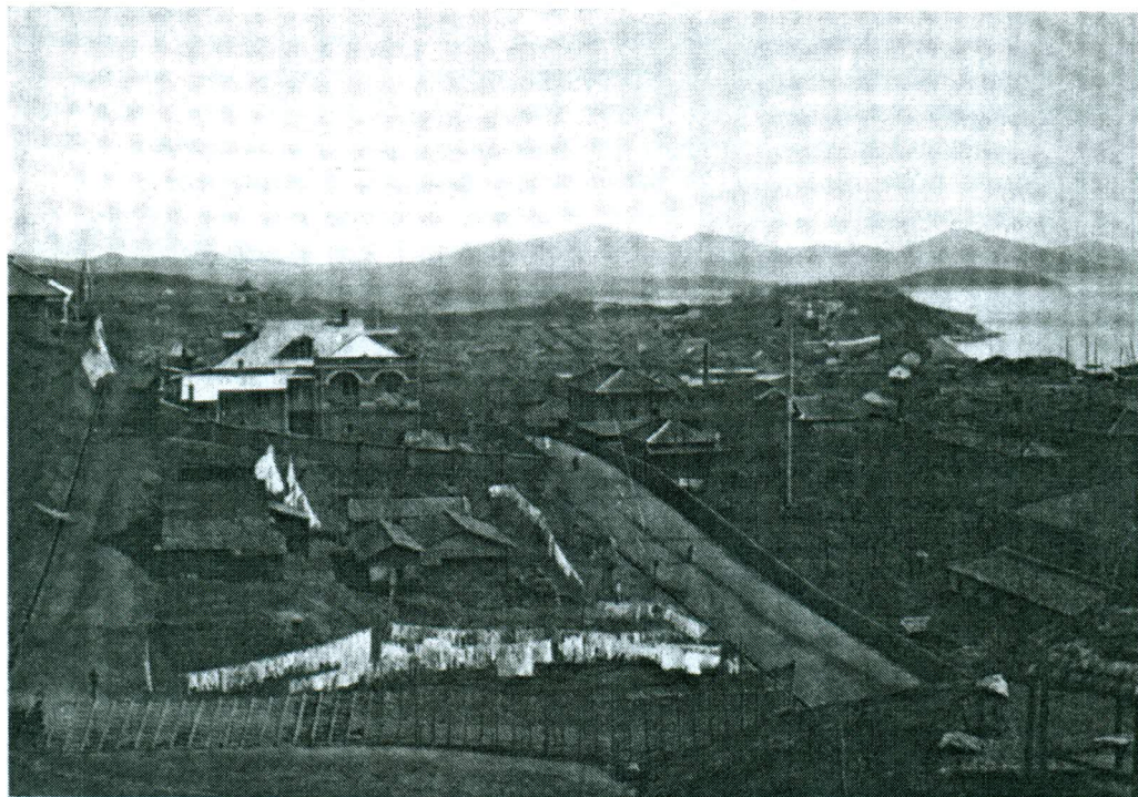
LA CONCESSIONE INTERNAZIONALE DI CEMULPO (GENERAL FOREIGN SETTLEMENT) (VISTA DA NORD).
