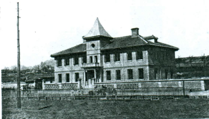
IL NUOVO HÔTEL DI SEUL PRESSO LA STAZIONE.
